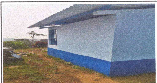
Foto 3: Cubierta y vidrios de cocina ya colocados en su totalidad.
