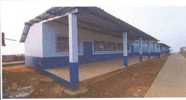
Foto 2. Pintura en paredes y colocacion de vidrios ya finalizados en modulo 2
