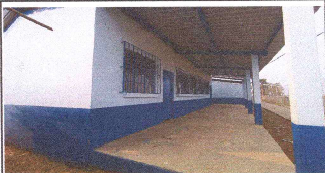
Foto 1. Mantenimiento ya finalizado en este modulo 2.
