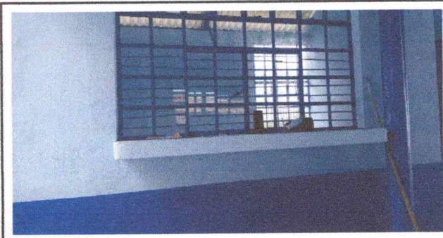
Foto 4: Ventanería y puerta mas cocacion de impermeabilizante en modulo decocina ya finalizado.
